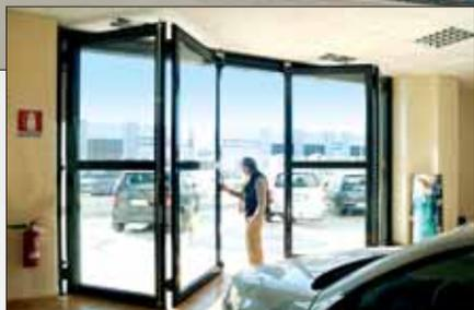
Il portone Mod. DI (doppio impacco) vetrato è costituito da ante realizzate con profili perimetrali in tubolare d'acciaio avente sezione ad "L" dim. 60x80mm, e traversi d'unione realizzati con profili in tubolare d'acciaio con sezione a "T" dim. 60x50mm, il tutto con finitura zincata e verniciata in tinta RAL a scelta con effetto bucciato.
